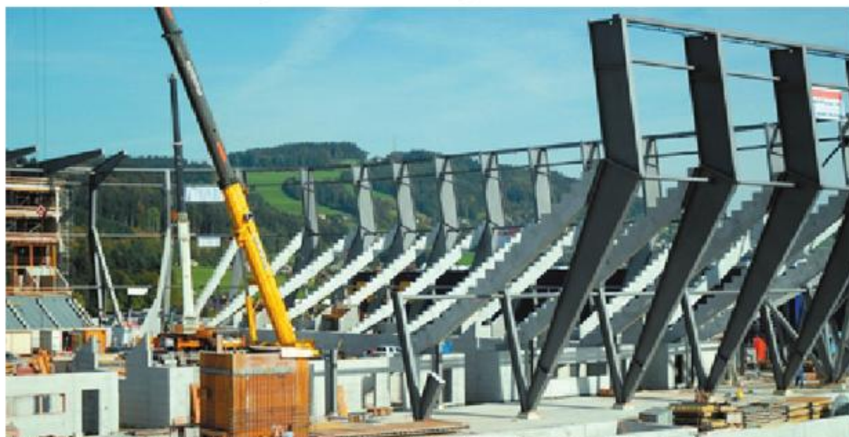
Bild: Das Stahlgerüst der Osttribüne (Quelle: afgarena.ch)
